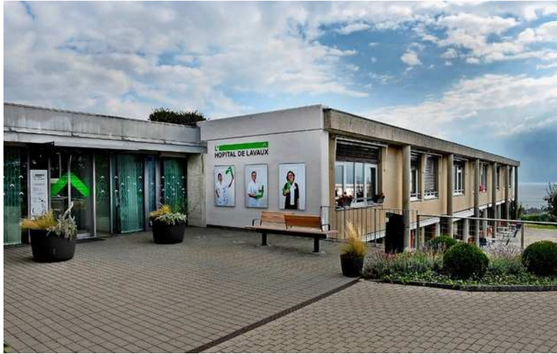
Un EMS de 60 places (contre 36 aujourd'hui) jouxtera le bâtiment hospitalier existant, qui sera rénové. Image: Chantal Dervev
